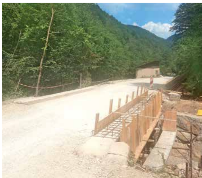
Na lokalni cesti Kopačnica–Podpleče poteka intenzivna sanacija. FOTO: LIDIJA RAZLOŽNIK
