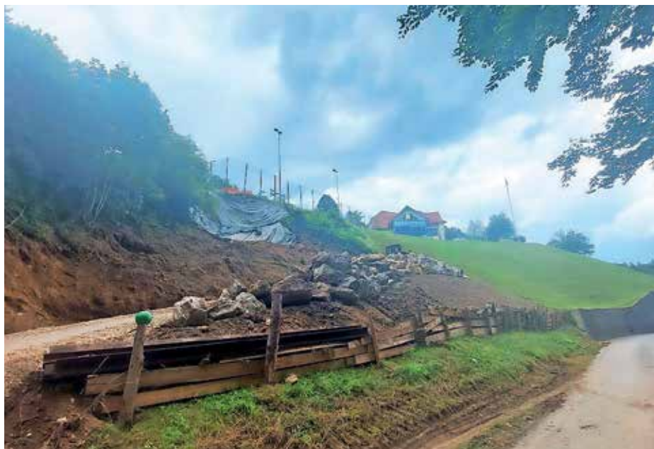
Sanacija plazu pod športnim igriščem pri podružnični šoli in vrtcu na Sovodnju
